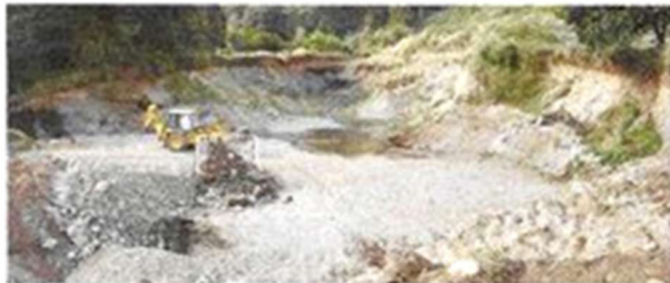
Sitio 10 Lag 013 SAN PEDRO 20: Vista pozo extracción áridos sobre el sitio
